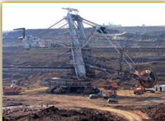
Figure 4. Investiciona popravka tehničkih sistema u RB „Kolubara“, (2018), [1]
